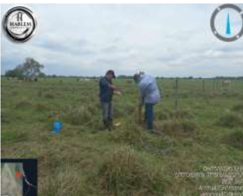
Fotografía No. 15. Tendido de alambre de púas.
