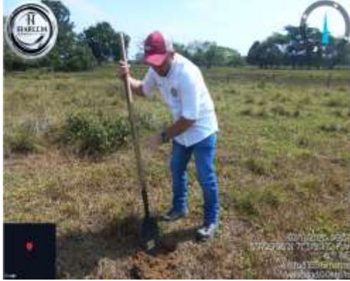
Fotografía No. 13. Ahoyado para postes.
