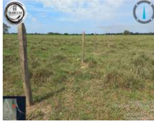
Fotografía No. 14. Establecimiento de postes.
