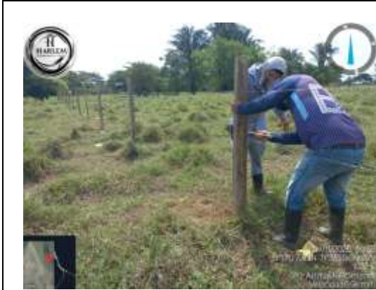
Fotografía No. 17. Establecimiento segundo hilo
