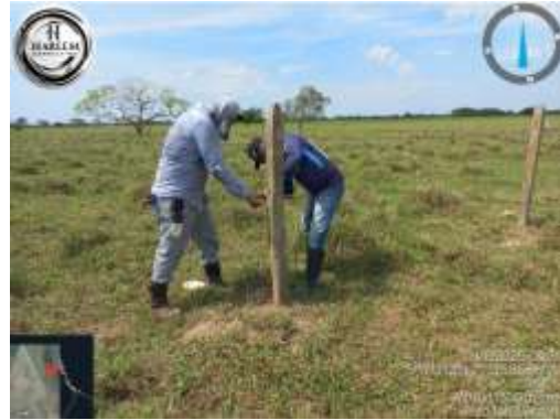
Fotografía No. 18. Establecimiento segundo hilo.
