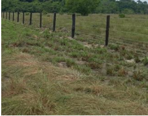
Fotografía 1. Postes inmunizados cercas.
