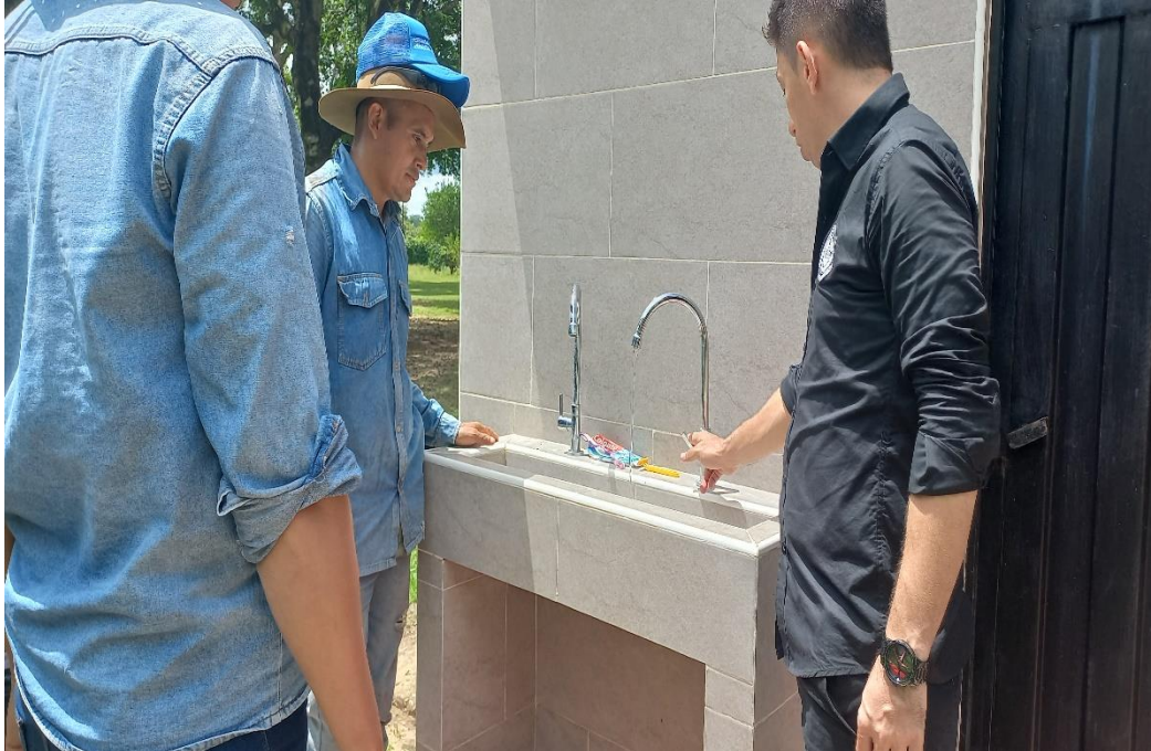
Fotografía No. 17. Practica de identificación de fugas y pérdidas de agua en los sistemas de distribución y control de la salida del recurso hídrico.
